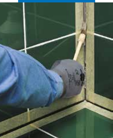
Application of Primer FD
